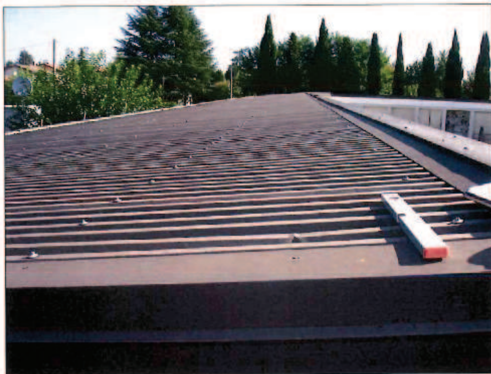
Foto 1: sito di installazione n. 9 moduli
