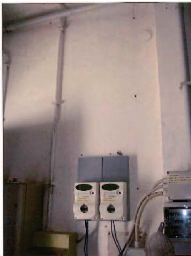
Foto 2: sito di installazione inverter e quadri elettrici
